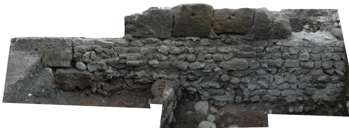
Fig. 42 – Vue de l'intégralité du parement est du mur oriental du bâtiment 5. MR 6033, avec ses gros blocs de molasse installés sur la fondation, et, à l'angle avec le mur sud MR 6032, d'autres blocs de grand appareil, mis au jour sous la conservation du Musée (secteur 6, clichés redressés), (E. Rouger, Inrap).
