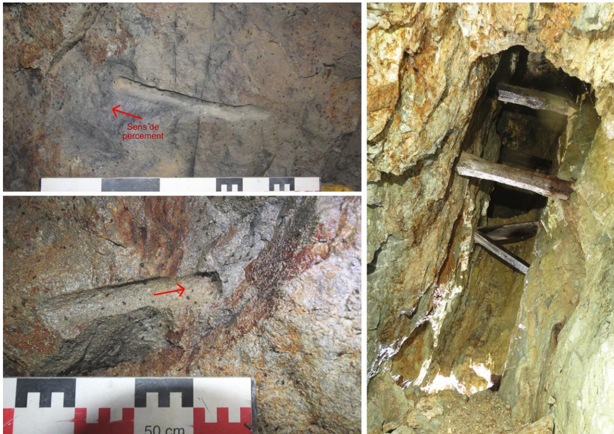
Fig. 7 – À gauche, traces de fleuret liées à l'utilisation de la poudre. À droite, étais en bois encore en place dans un chantier souterrain. (Clichés : G. et R. Bonnamour).
